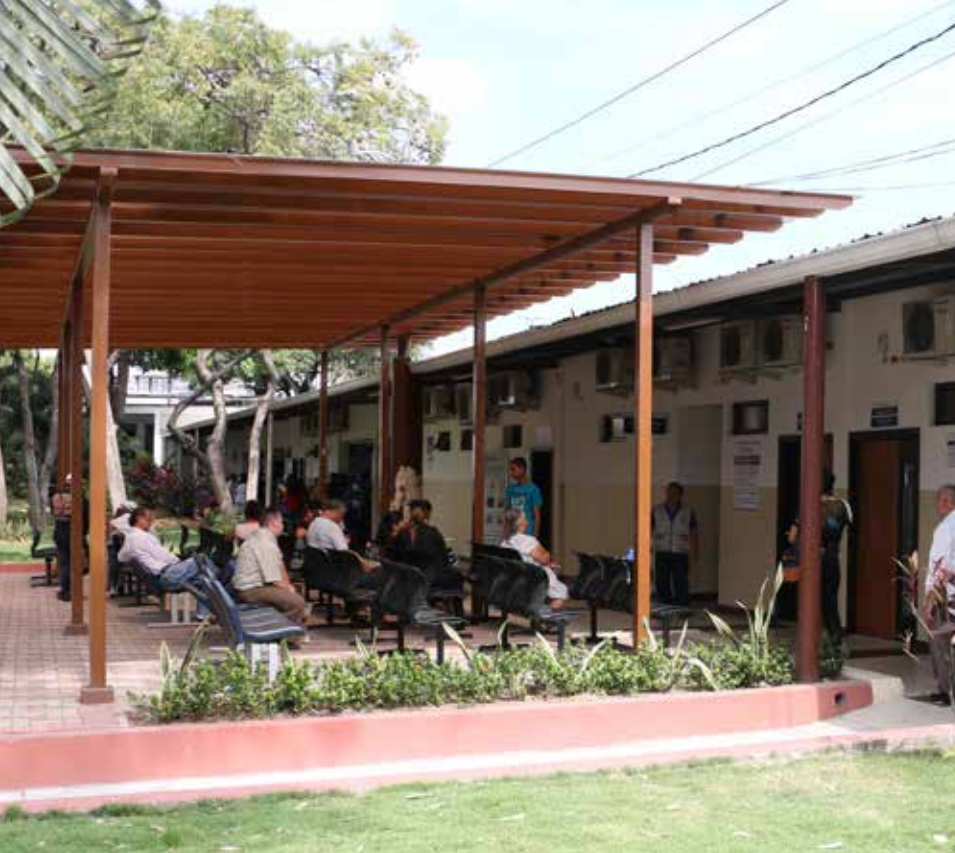
» Áreas de espera remodelada de la Consulta Externa del Instituto de Neurociencias.
