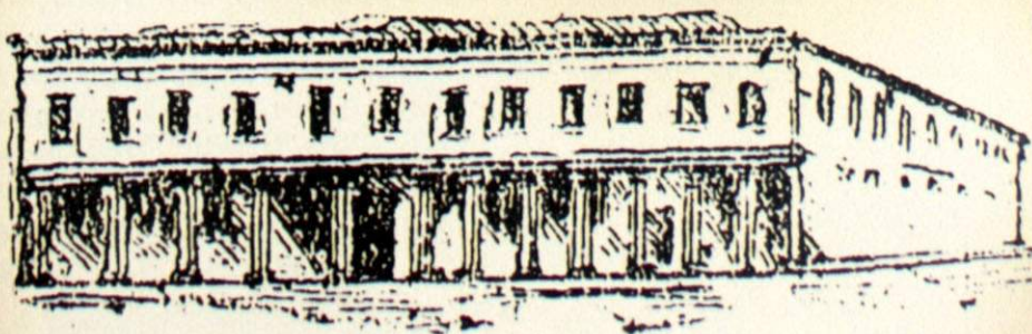
Hospital Civil destruido por el incendio
