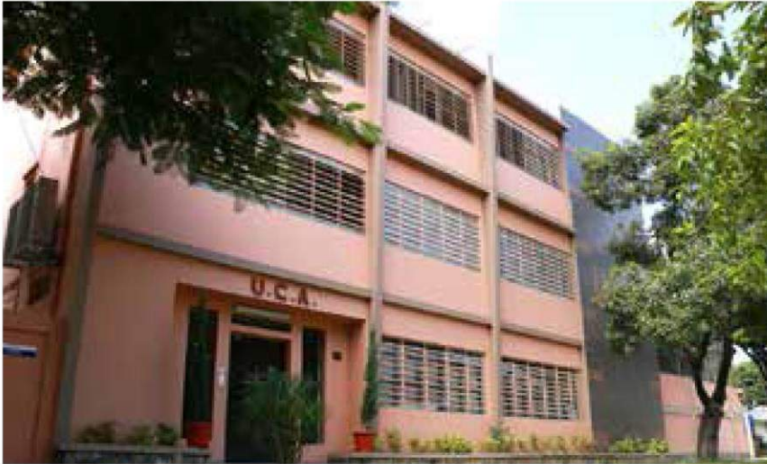
» Edificio donde funciona la Unidad de Conductas Adictivas - Varones
